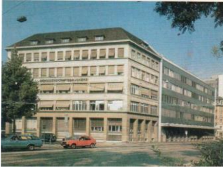
1965: Alt- und Neubau, Stauffacherstrasse in Zürich.
